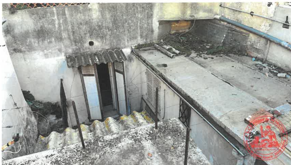
Vue des deux caves
