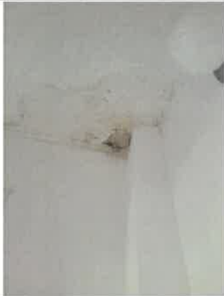
Photo n° présence d'infiltration Localisation sur croquis : 2ème étage - Wc Ouvrage : plafond
